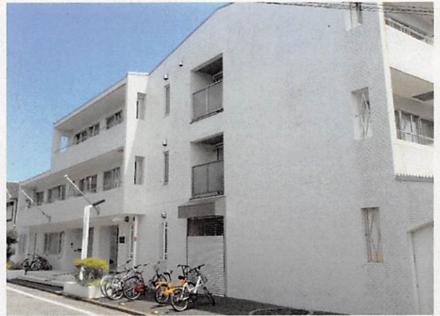
鉄筋コンクリート地上3階地下1階建 平成5年10月完成
